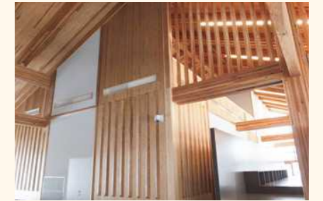
■内装壁施工例
