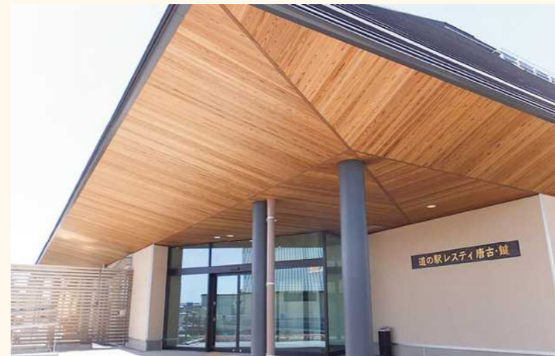
■軒天井施工例
